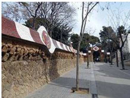
Muro de cerca del parque y entrada lateral por la calle de Olot
