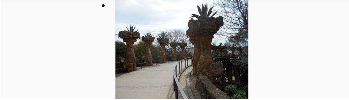
Viaducto de las Jardineras
